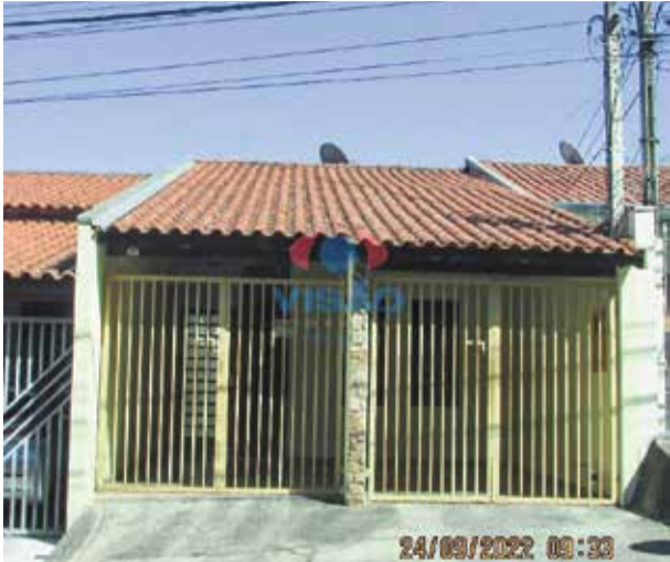
1 ref site 3150 - Casa Jardim Primavera - 2 dorm , sala, coz, banheiro, área de serviço R$ 1.500,00 + IPTU
