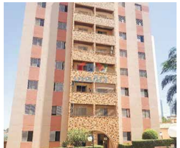
12 ref site 32963 - Apartamento Jardim Pompéia - 3 dorm, coz, sala, suíte, banheiro, área serviço e garagem - R$ 510.000,00
