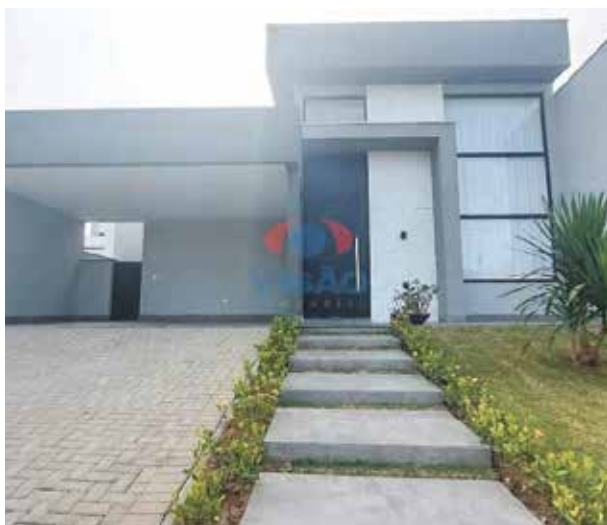
7 Ref site 32940- Casa Jardins Di Roma - 3 dorm , banheiro , suíte , sala , coz , lavanderia e garagem - R$ 1.475.000,00
