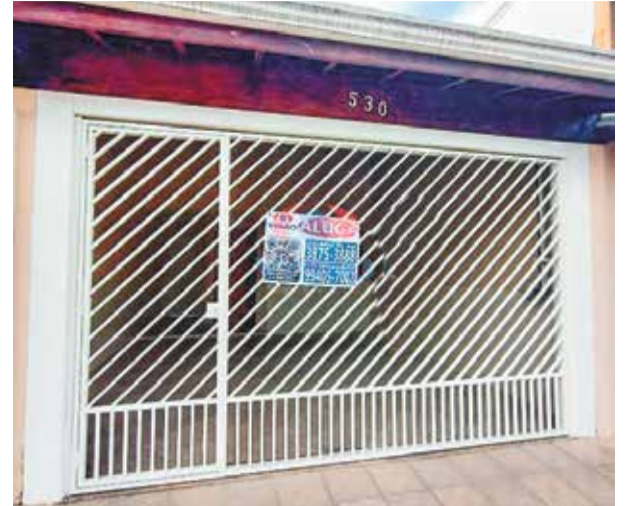
3 ref site 2015 - Casa Residencial Monte Verde - 2 dorm , sala , cozinha , 2 banheiros , 1 suite , área de serviço - R$ 2.000 + IPTU
