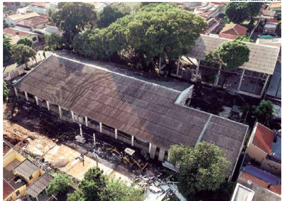
O projeto inclui a construção de sala multiuso, sala de informática, duas salas de reforço e uma sala de leitura/biblioteca
