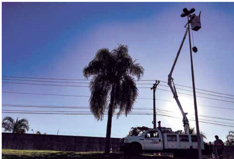
Na região central, João Pioli e no Parque Ecológico já foram instaladas 765 luminárias
