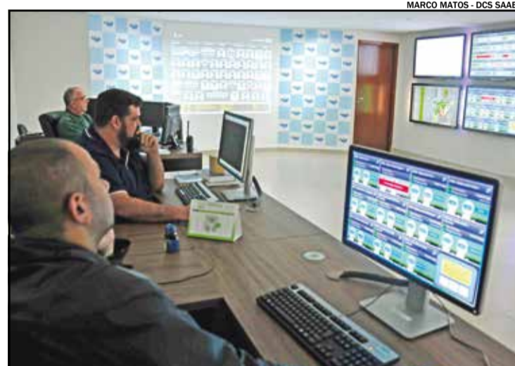
Para monitorar à distância a distribuição de água no município, o Saae utiliza um CCO que funciona 24 horas por dia
