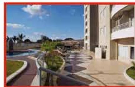
AP01360 TORRES DA LIBERDADE PERMUTA POR TERRENO DENTRO OU FORA DE CONDOMÍNIO - R$ 450 MIL
