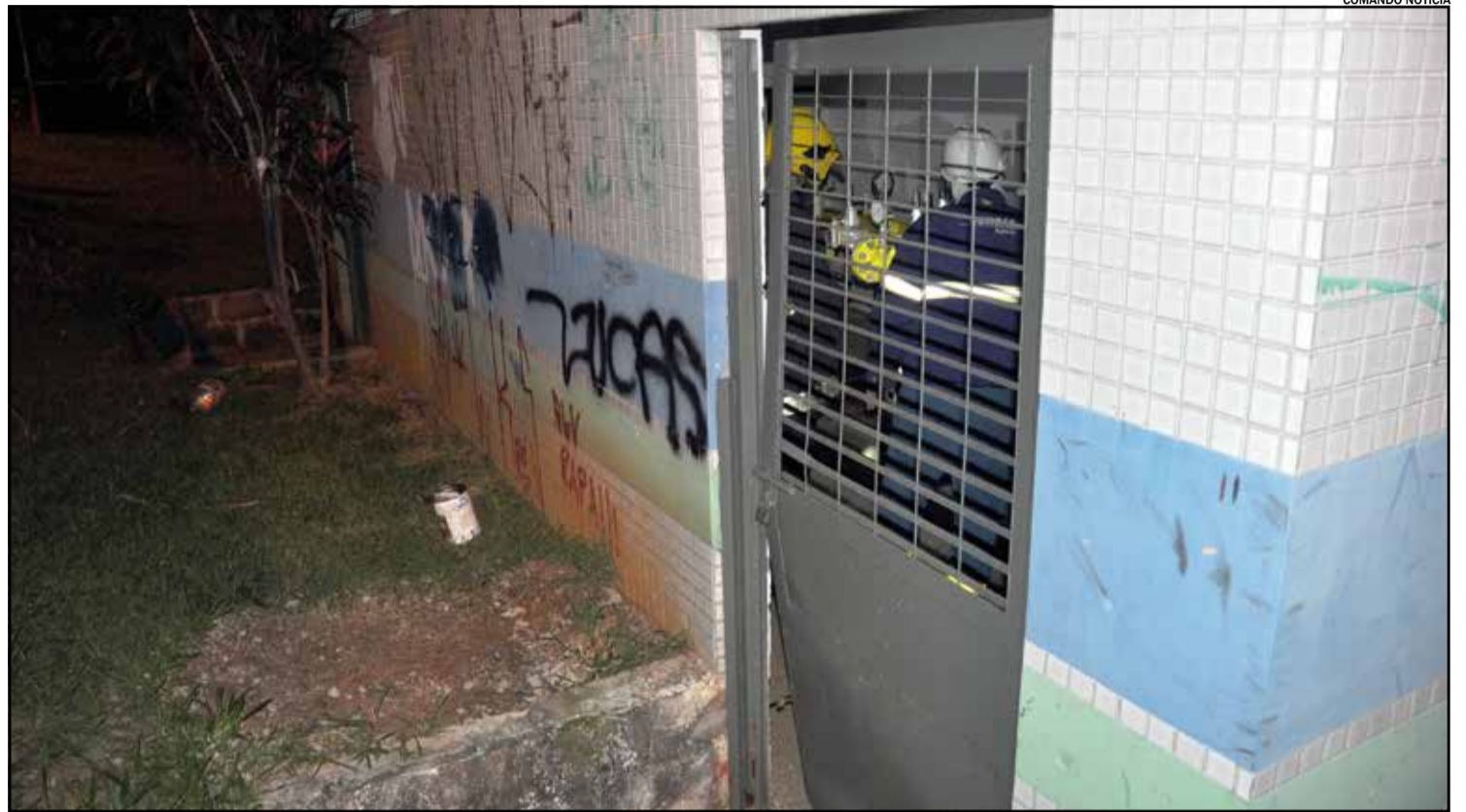
O vazamento ocorreu em uma Central de Controle situada no bairro Brigadeiro Faria Lima (Cecap)
