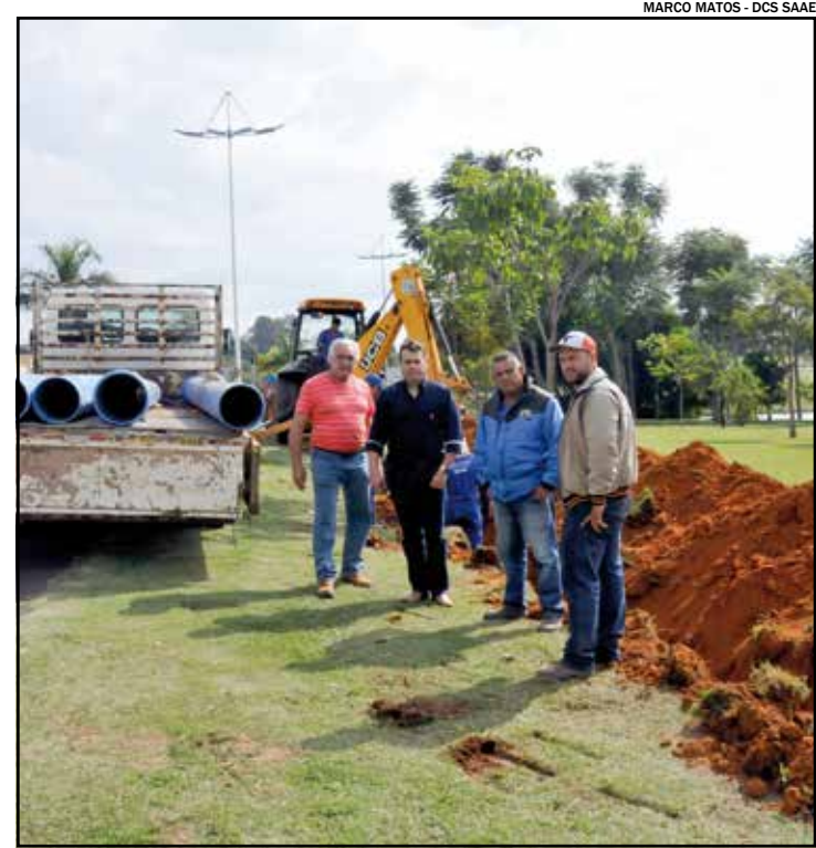
Obra tem cerca de 1,4 metros de extensão e tubulação de 300 mm de diâmetro
