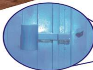
FECHADURA DIFERENCIADA permite colocar o cadeado protegido
