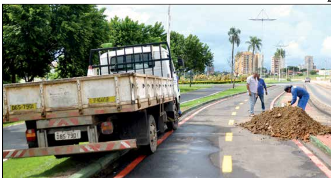
Equipes de manutenção elétrica e de trânsito atuaram em plantão
