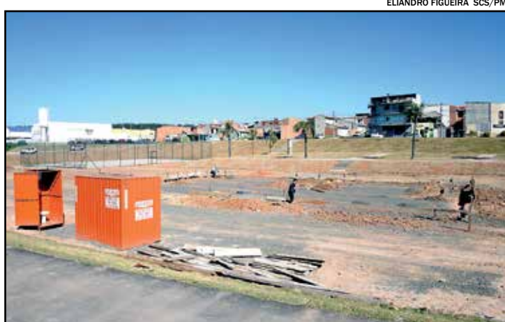
Obra tem previsão para ser concluída em três meses
