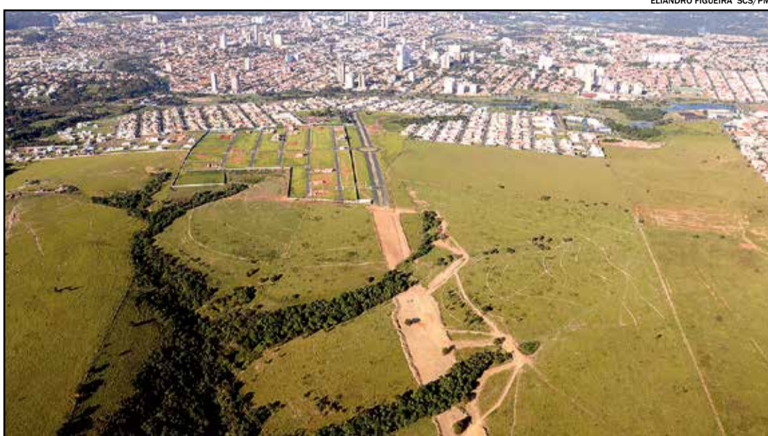
Os dois trechos da obra do anel viário totalizam cerca de cinco quilômetros
