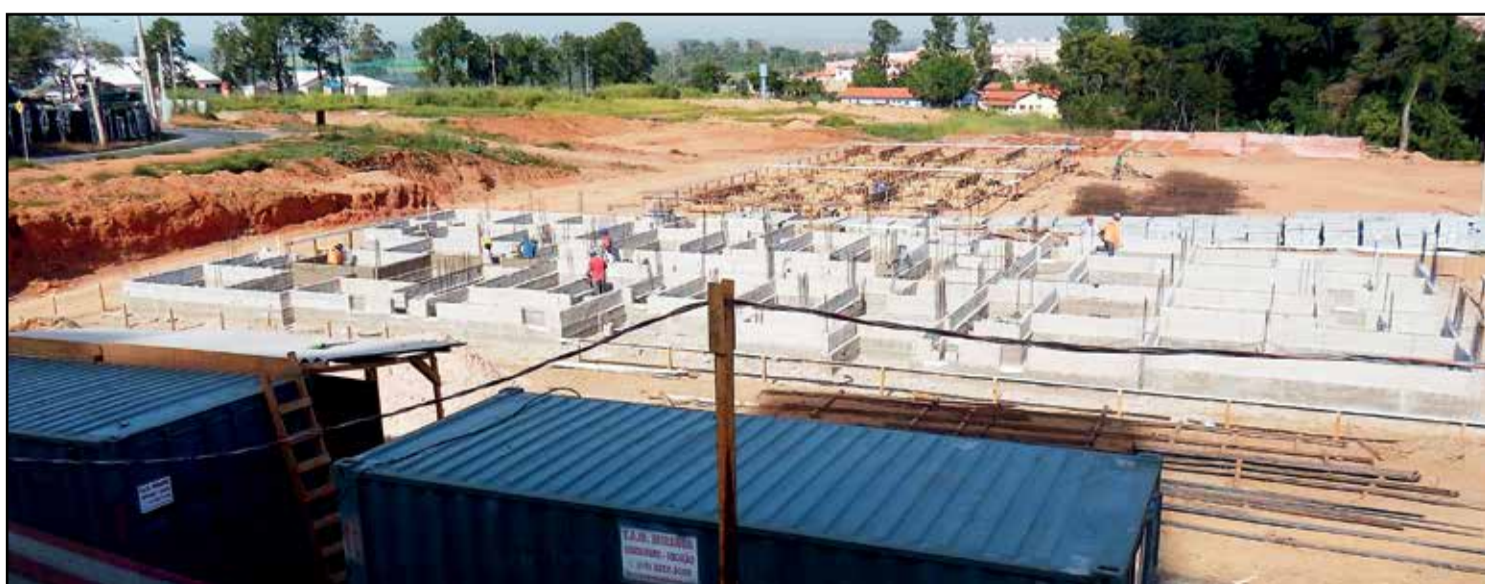
Obras em ritmo avançado
