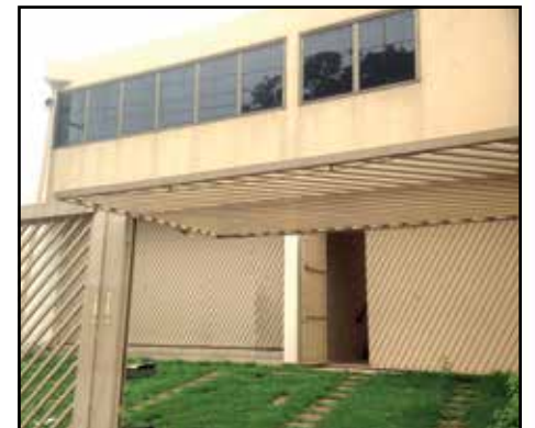
CA10011 CENTRO - AT.262m 2 AC.250m 2 - TERREO: AMPLO SALÃO COM WC / DESPEJO / GAR.4 VAGAS / PORTÃO ELET. - SUPERIOR: AMPLA SALA 2 AMB. / COZ.AMER. / DESPENSA / 2 DORM.(SUITE + CLOSET) / WC / GAR.1+2 VAGAS LATERAIS / PORTÃO ELET. / AMBOS OS PISOS: CAMERAS / PORTAS BLINDADAS / AQUEC.SOLAR. R$ 5.000,00 + IPTU
