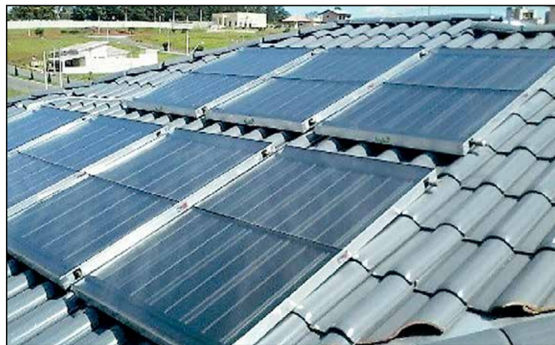
Instalação residencial de placa Fotovoltaica
