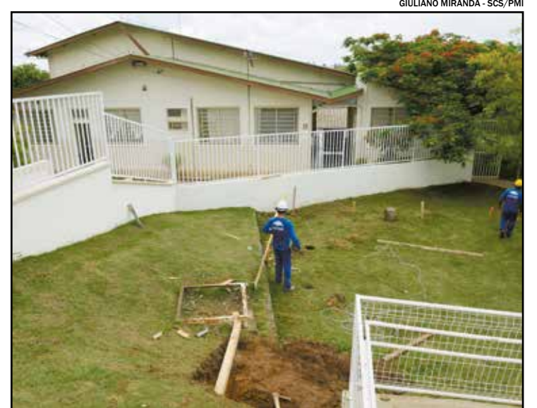
Obra em escola terá investimentos no valor de R$1.989.683,57
