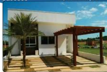
CASA TERREA, 3 DORM SENDO 1 SUÍTE, 2 VAGAS DE GARAGEM - AT 150 m 2 AC 104 m 2 COND. MONTREAL
