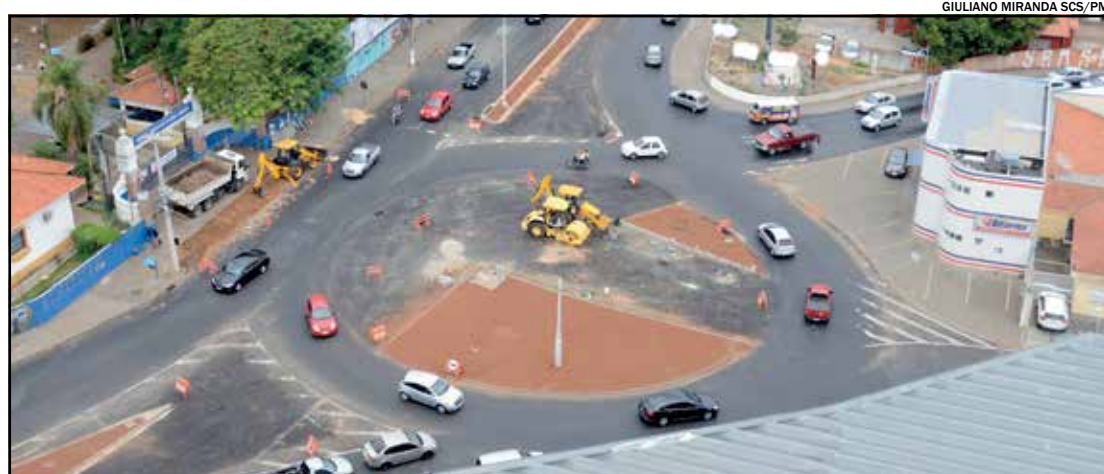
Melhorias no trecho deve desafogar o trânsito carregado na região, principalmente nos horários de pico
