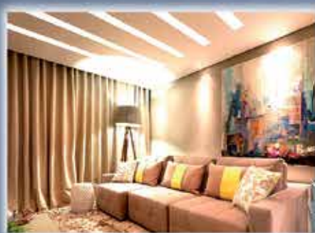
FORRO DRYWALL E CORTE LUMINOSO
