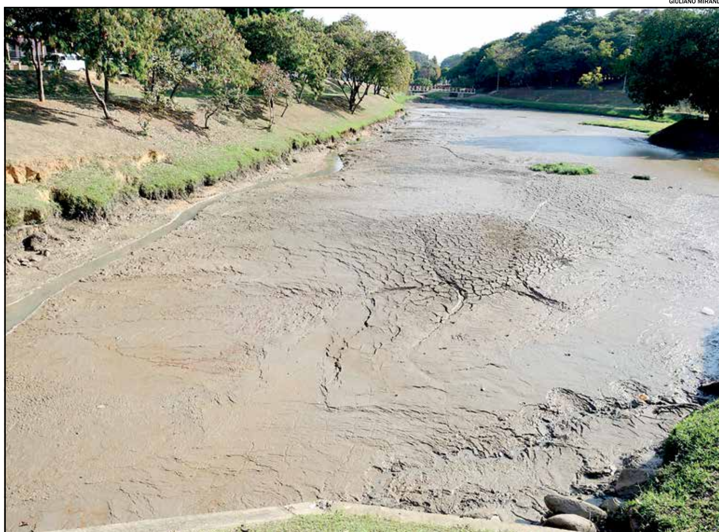
Segundo o Saae, o desassoreamento deve iniciar na próxima semana
