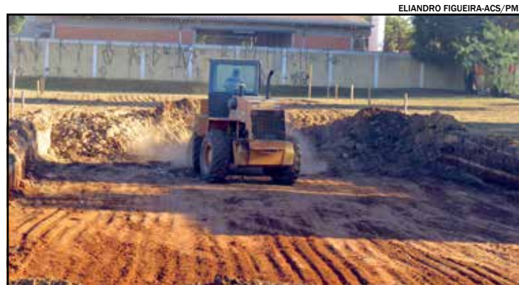
A nova piscina começou a ser construída e deve ficar pronta em 8 meses
