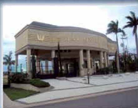
MOLDURA DE CONCRETO
