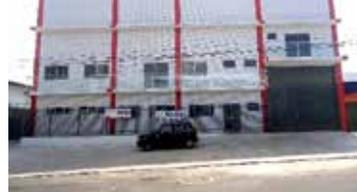
**GL00304** - Galpão Industrial de 1.600 m<sup>2</sup>, construído em terreno de 2.350 m<sup>2</sup>, possui escritórios, vestiários, refeitório e sala da diretoria, capacidade de energia elétrica de 75 Kwa, resistência do piso de 5 ton/m<sup>2</sup>, pé direito de 9 m, sistema construtivo: Estrutura metálica e cobertura de telha modular metálica LOCAÇÃO R\$ 29.000,00
