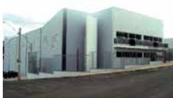
**GL00256** - Galpão Industrial com 973,89 M<sup>2</sup>, capacidade de energia elétrica de 75 Kwa, resistência do piso de 5 ton/m<sup>2</sup>, pé direito de 8 m, sistema construtivo: pré-moldado/alvenaria LOCAÇÃO R\$ 15.000,00
