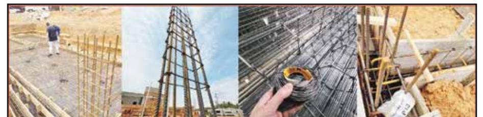
Ferragens etiquetadas para facilitar a execução da obra
