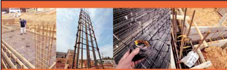
Ferragens etiquetadas para facilitar a execução da obra
