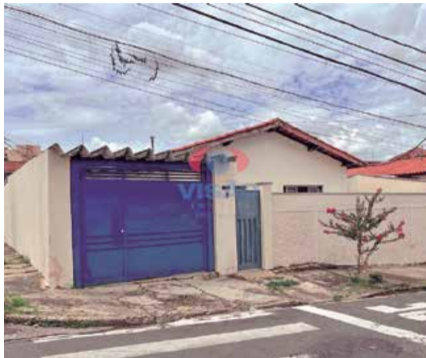
8 ref site 33769 - Casa Vila Furlan - 3 dorm , banheiro, sala, coz, área de serviço e garagem - R$ 480.000,00
